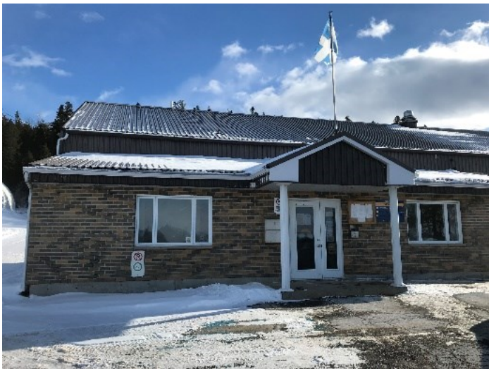
Édifice municipal de Sainte-Anne-de-la-Pocatière
